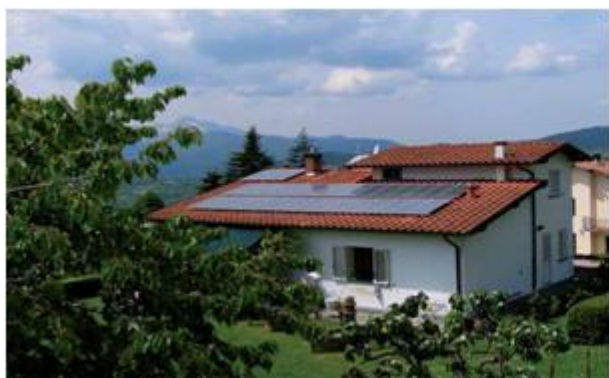
impianto a servizio di abitazione
